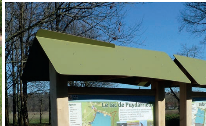
Toit en compact
